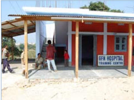
Die Krankenstation macht große Fortschritte
