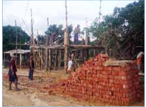
Schritt für Schritt wächst das Krankenhaus in Darchawi
