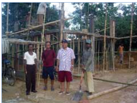
Der Krankenhausbau schreitet voran
