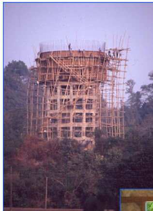
Bau eines Wasserspeichers
